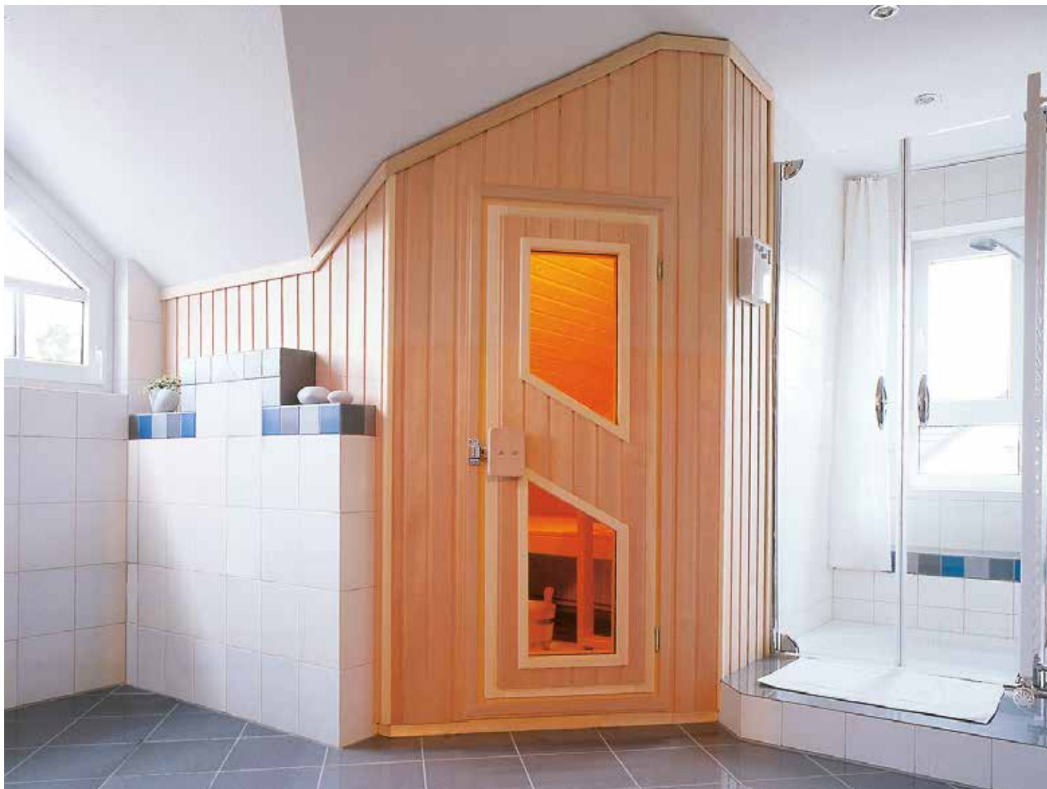
Individualeinbau in einem Dachgeschoss-Bad
